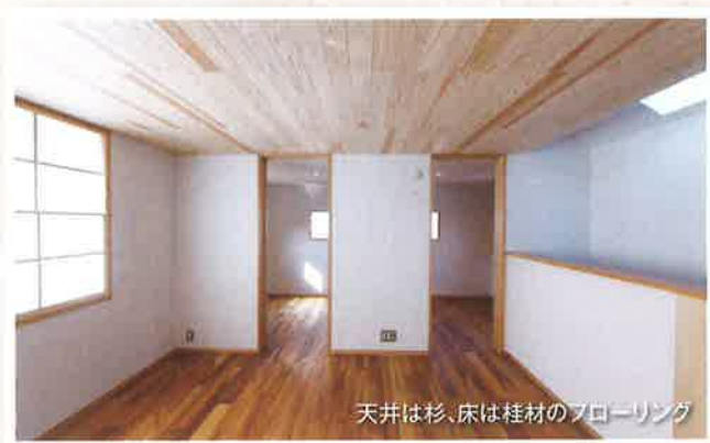
天井は杉、床は桂材のフローリング
