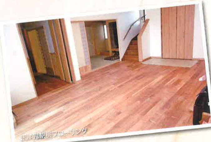
天井は杉、床は桂材のフローリング
